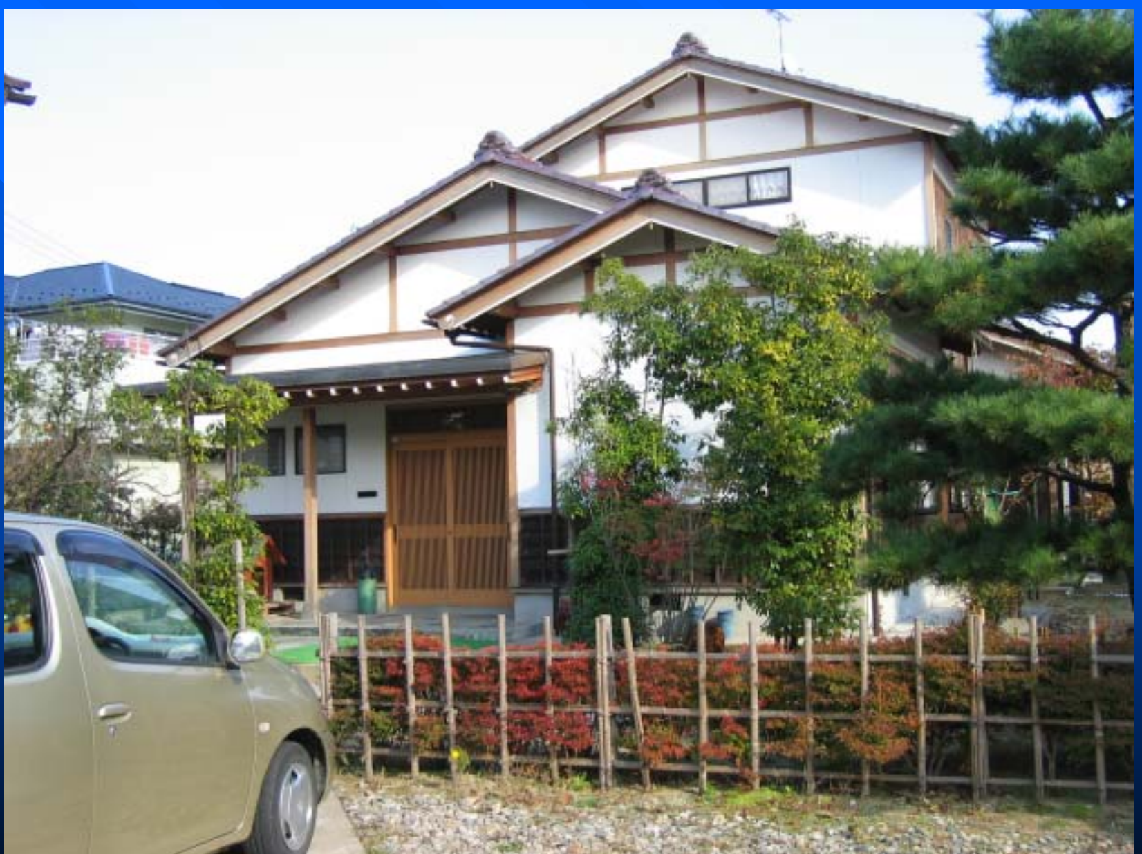
修景助成された新築住宅
