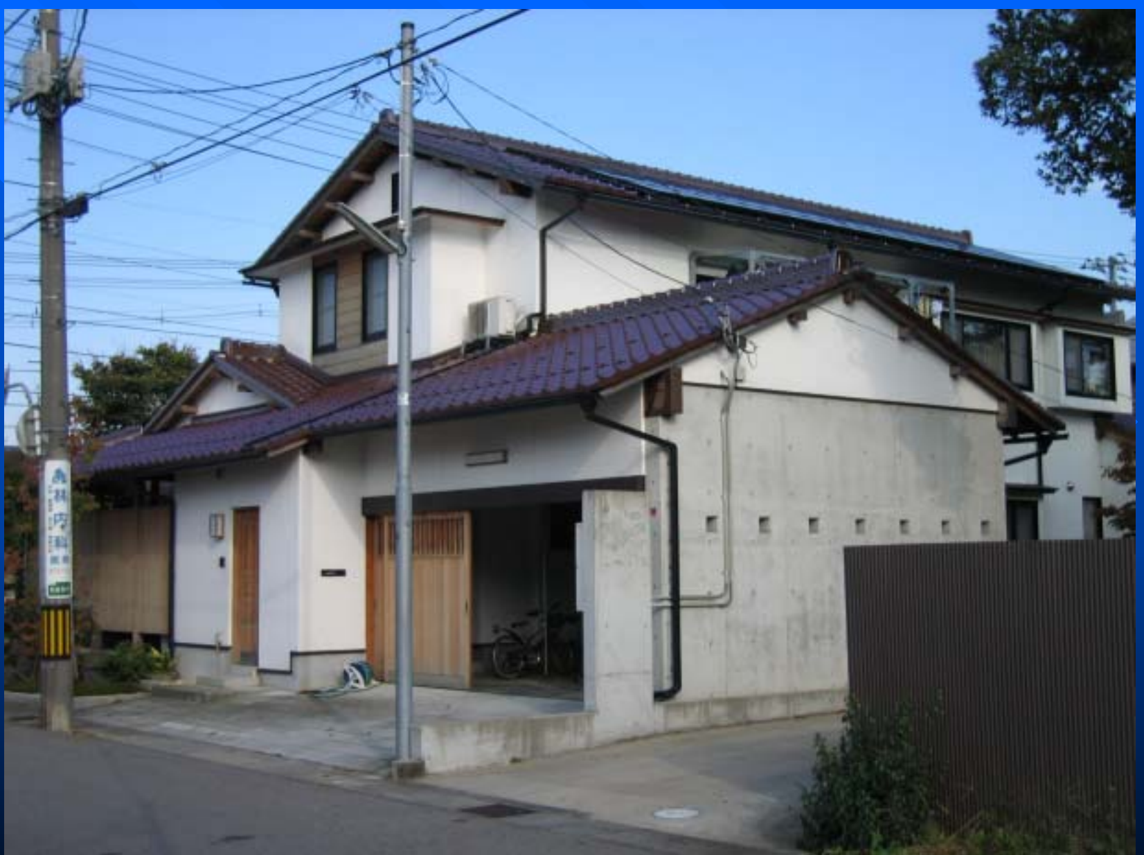
修景助成された新築住宅
