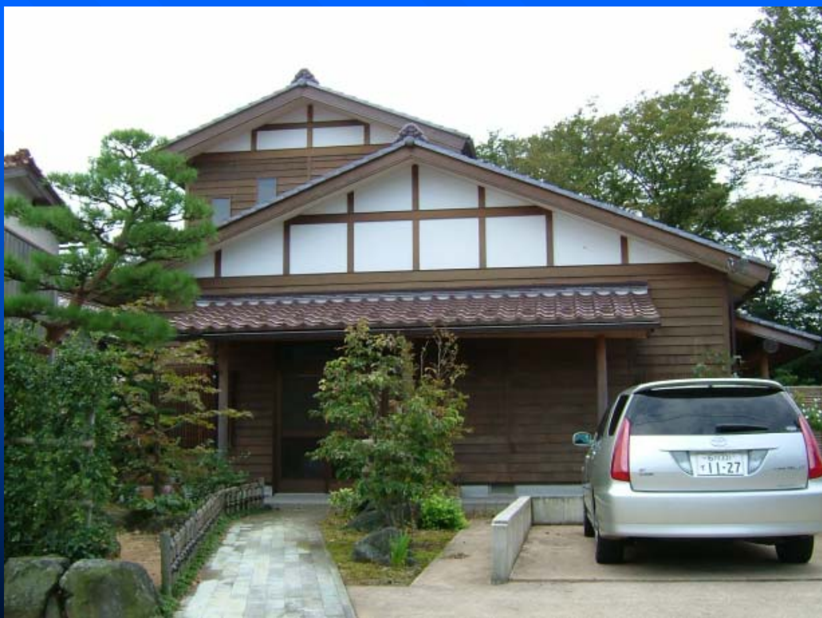
修景助成された新築住宅
