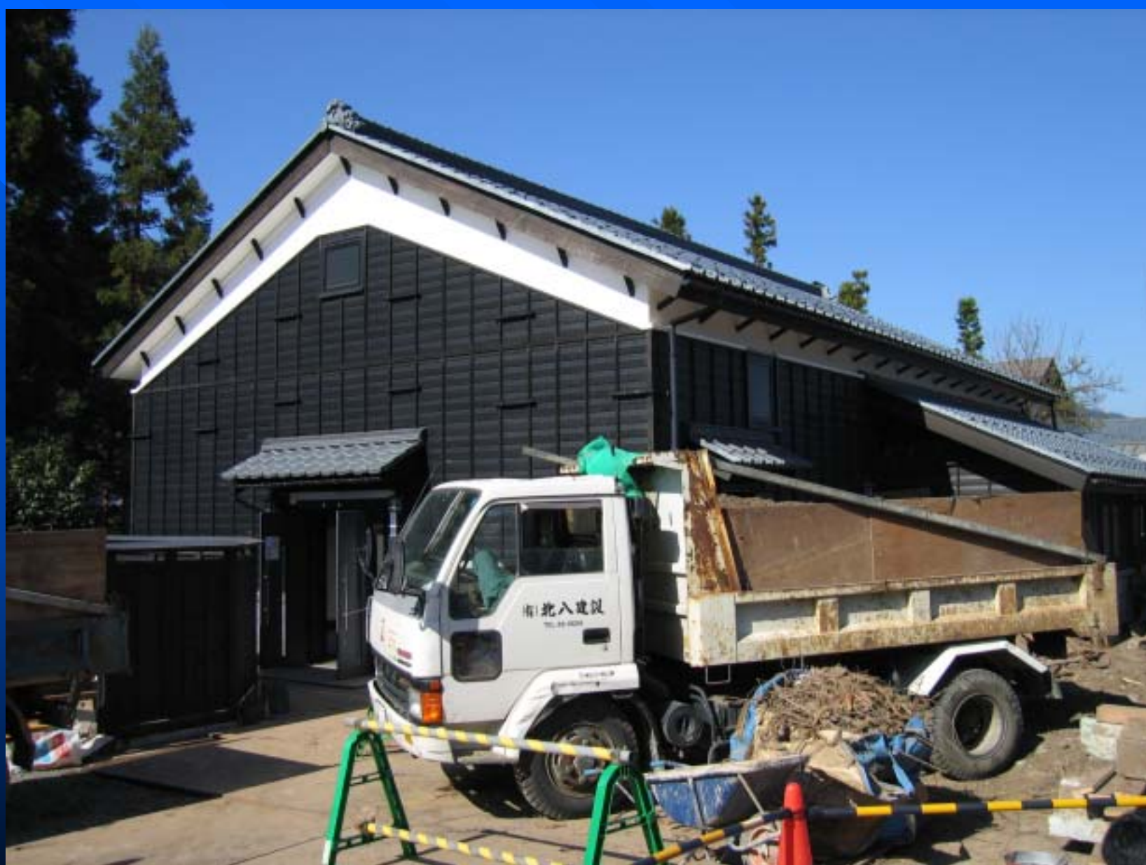
平蔵外観 (H11年度整備)
