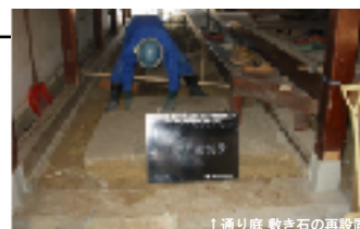
↑通り庭 敷き石の再設置
