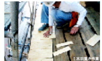
↑木羽葺き作業
