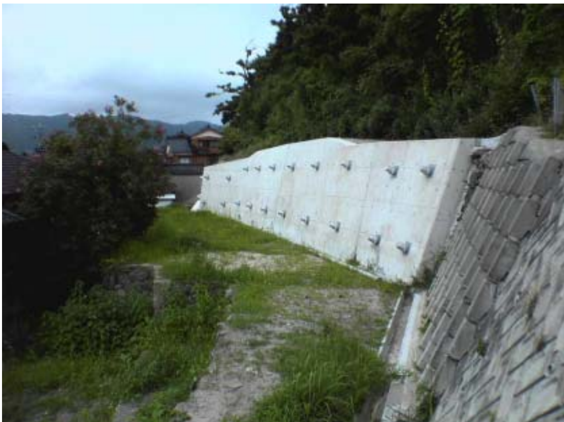
⑫現在の土留め
