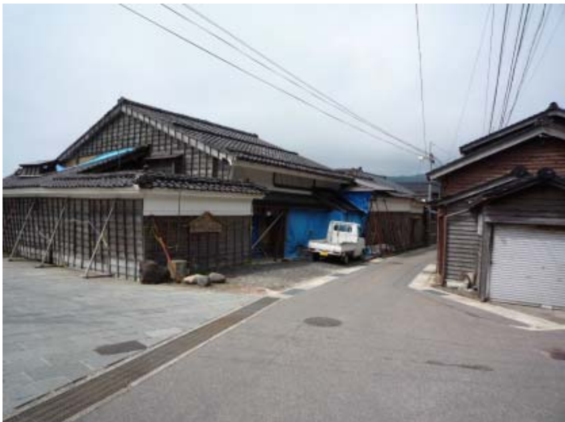
②主屋外観（輪島市が今後復原工事を実施する）
