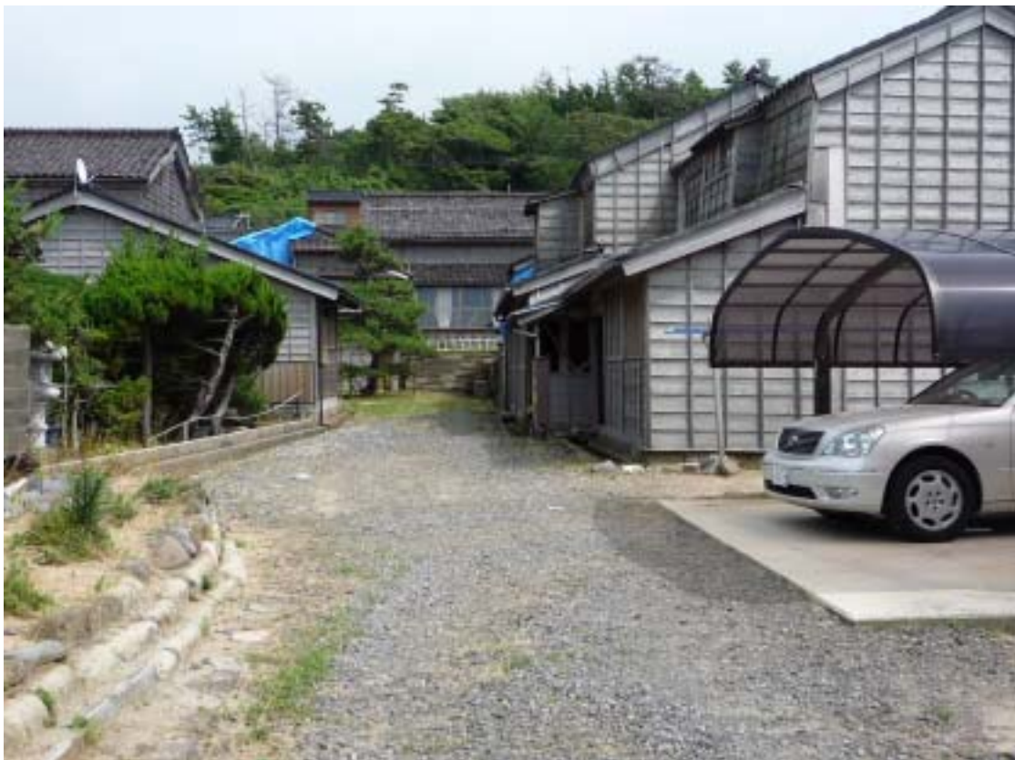
⑧国道側から主屋を見る（奥が主屋、右は土蔵）
